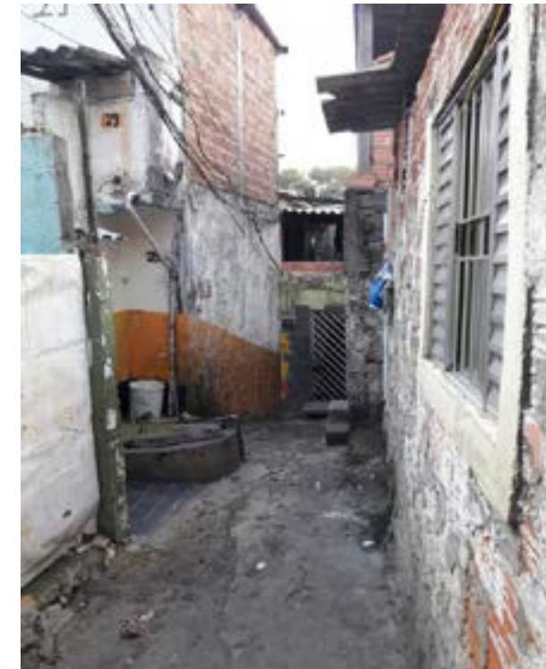
ÁREA INTERNA DA COMUNIDADE PALETS SOB CORREGO Tipo área: DESLIZAMENTOS Localidade: VILA MUNICIPAL VILA MUNICIPAL
