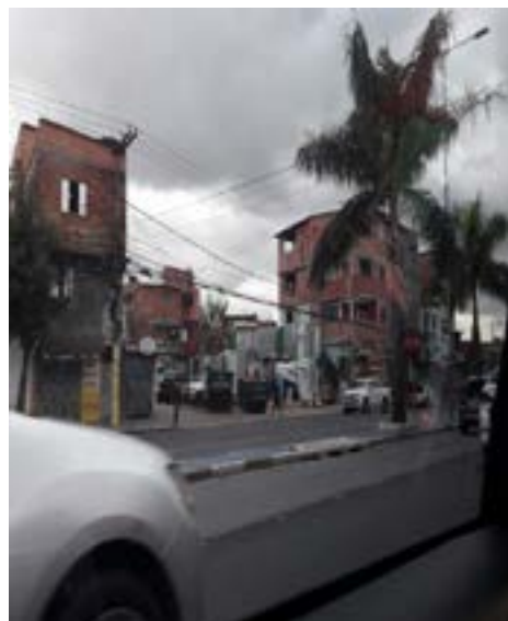
ÁREA PASSÍVEL DE INCÊNDIOS, DESLIZAMENTOS E ENXURRADAS
