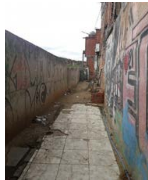
ÁREA INTERNA DA COMUNIDADE Tipo área: DESLIZAMENTOS Localidade: VILA MUNICIPAL VILA MUNICIPAL
